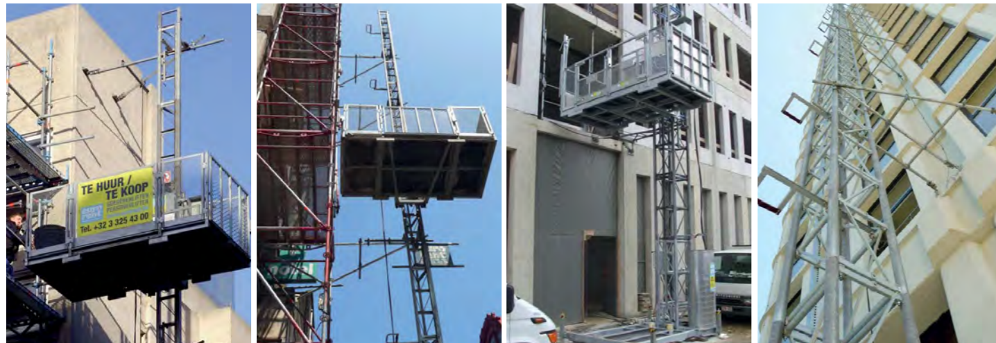
Verankering aan betonnen gevelelementen
