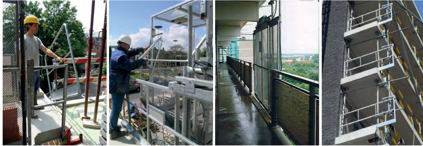
Kantelhekken met bediening met daal/stopknop
