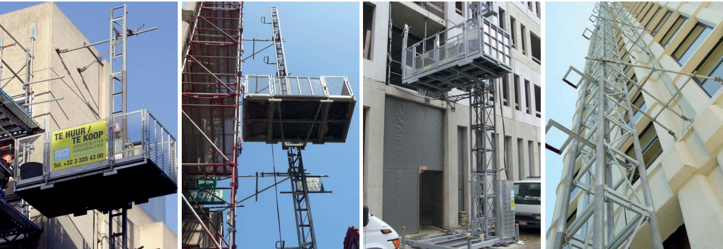
Verankering aan betonnen gevelelementen
