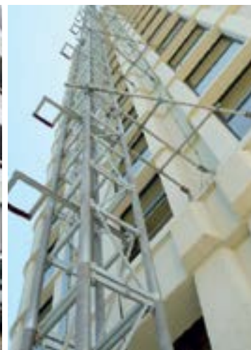
Schoring met knikverkortingen opgebouwd met steigerpijpen en koppelstukken
