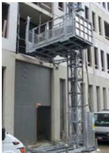
Basisstructuur transportsteiger en afschoring met standaard mastuithouder
