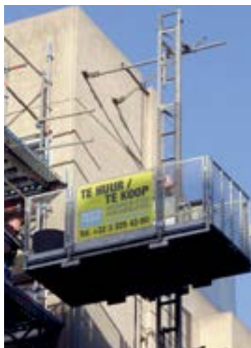
Verankering aan betonnen gevelelementen
