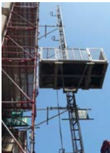
Rechtstreekse schoring aan gebouw bij steiger
