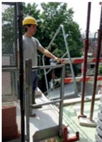
Kantelhekken met bediening met daal/stopknop
