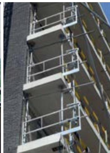
Etageschuifhekken met blokkeermechanisme
