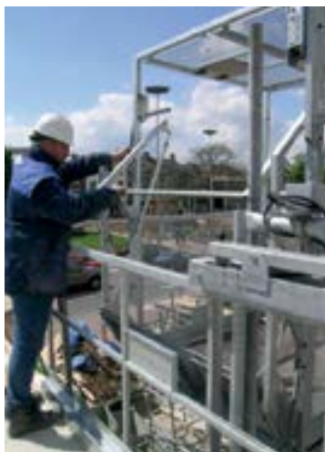
Laadklep met zijdelingse uitvalbeveiliging
