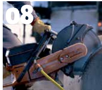
08 H02 | BETON- EN VLOERBEWERKING
