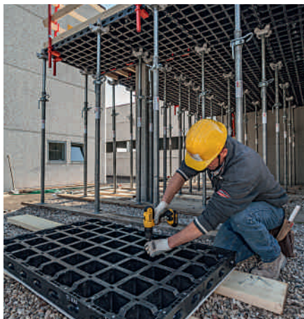
1. Losmaken van de schroeven.
