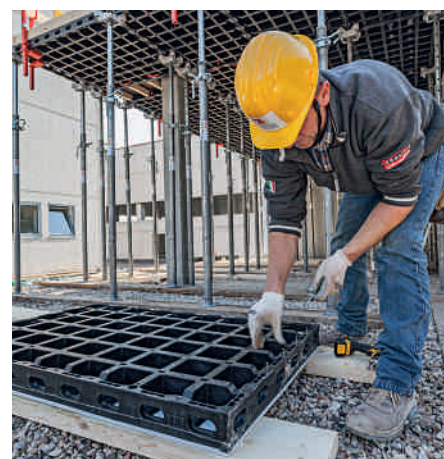
4. Vastschroeven van de nieuwe bekistingsplaat.
