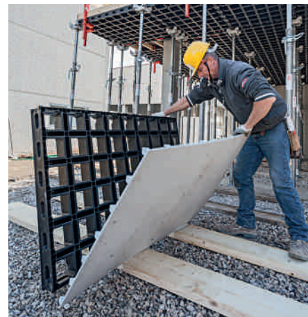
2. Verwijderen van de beschadigde bekistingsplaat.
