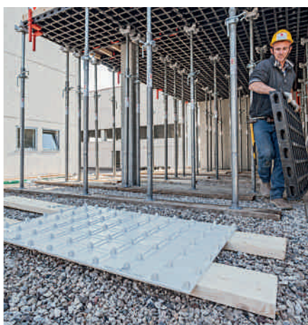
3. Gereedmaken van de nieuwe bekistingsplaat.
