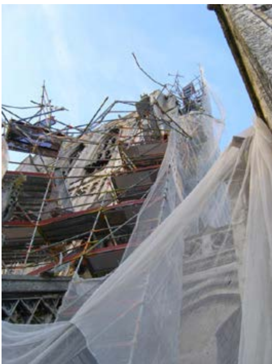
Figuur 50: gevolg van slechte verankering
