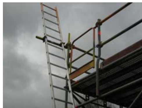
Figuur 37: toegang via externe ladder &amp; poortje
