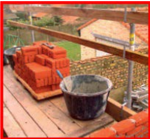
Figuur 47: Voorbeeld belasting op schraag
