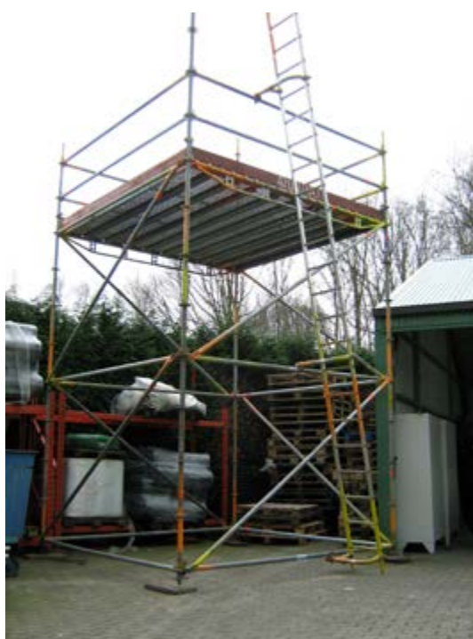
Figuur 38: Toegang via externe ladder
